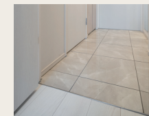
玄関・廊下・床タイル張り
